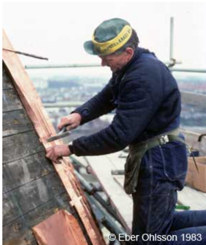
Plåtslageriarbete på Södervärnstornets tak den 14 april 1983.
