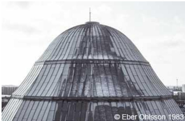
Inspektion av Södervärnstorns takkupol, fotograferad (NO) från en kranbils hisskorg den 3 februari 1983.
