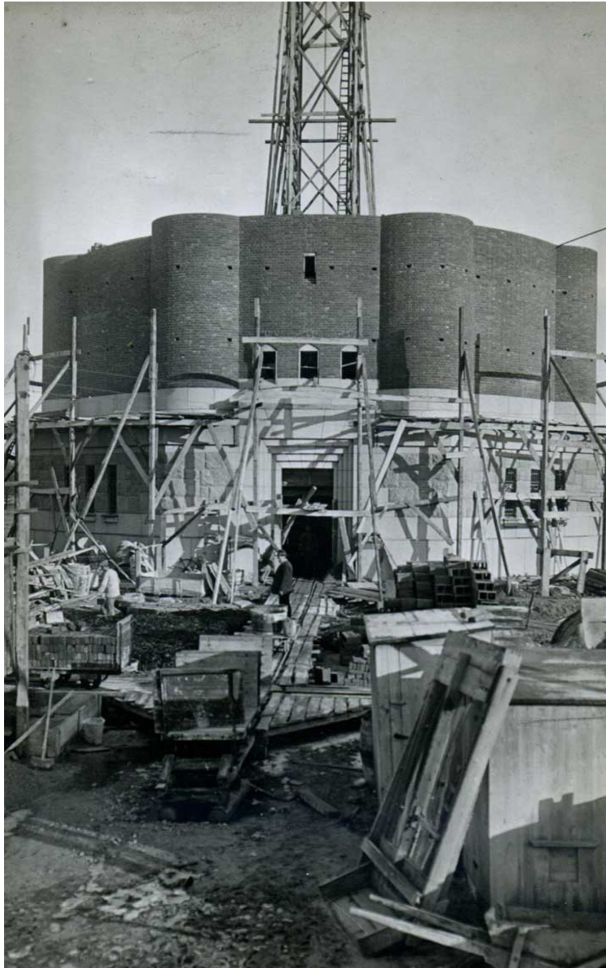
Konstruktion av tornet (Kindblad 2024)
