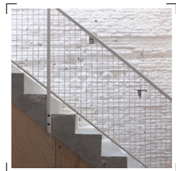
Nät av stål
