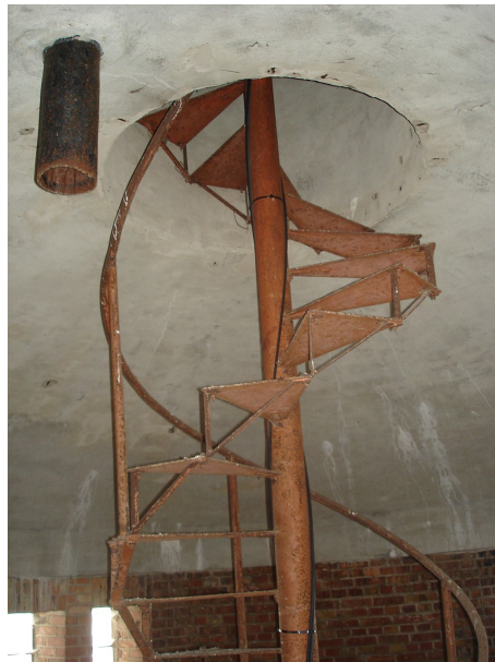
"Rummet" under cisternen med spiraltrappan som går upp genom cisternen. Röret i förgrunden har troligen varit för bottentömning.
