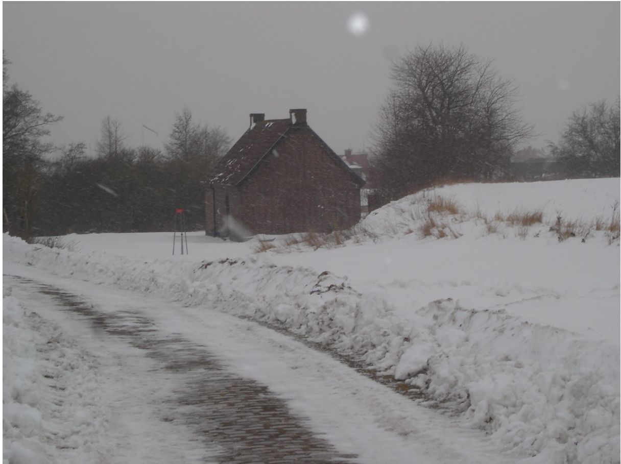
Pumphuset och den stensatta vägen till vattentornet, båda tillkomna samtidigt med vattentornet.
