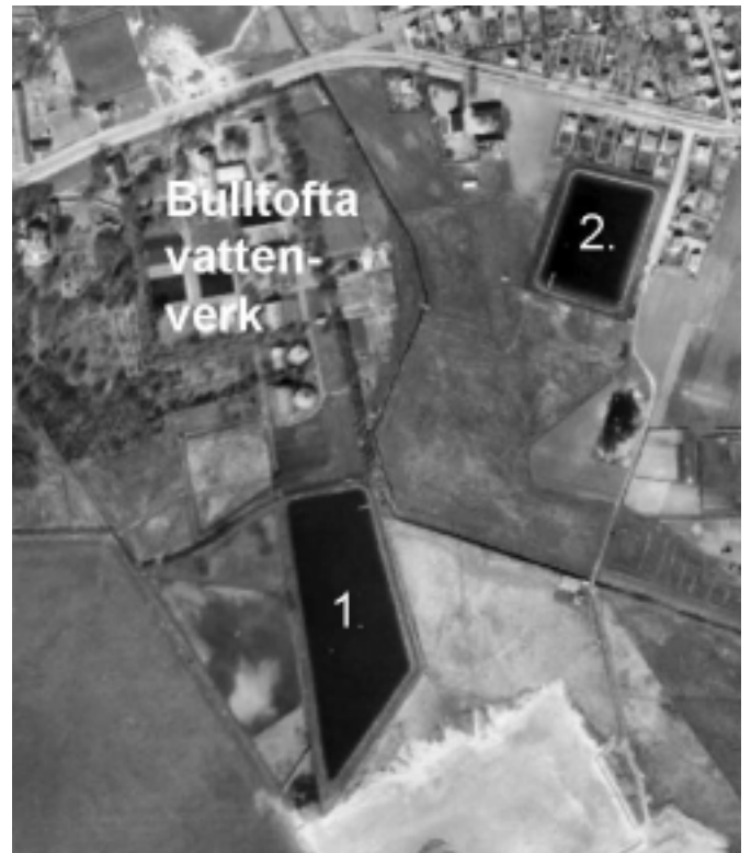
Bulltofta vattenverk med reservdammarna 1 och 2. Flygfoto 1940-talet.
