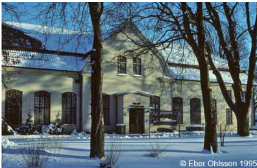
Bulltofta vattenverk julafton 1995.
