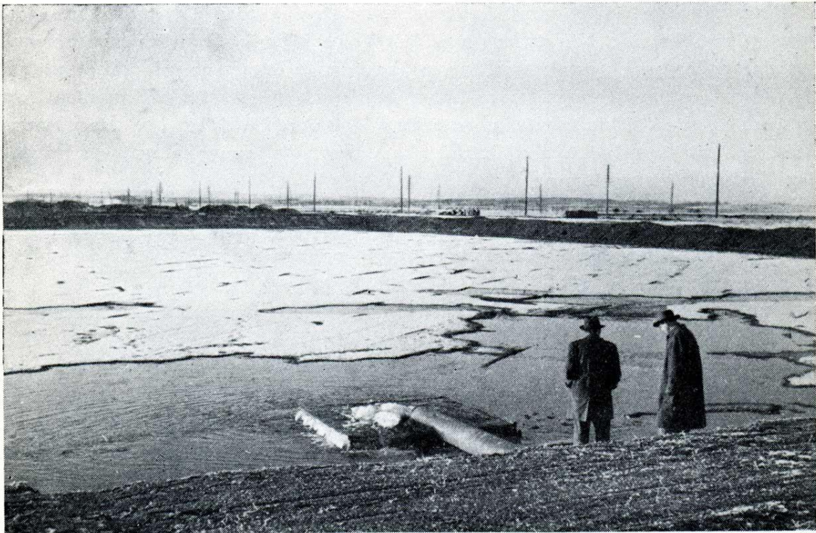
Fig. 3. Vattenverket i Vomb. Infiltrationsbassäng.
