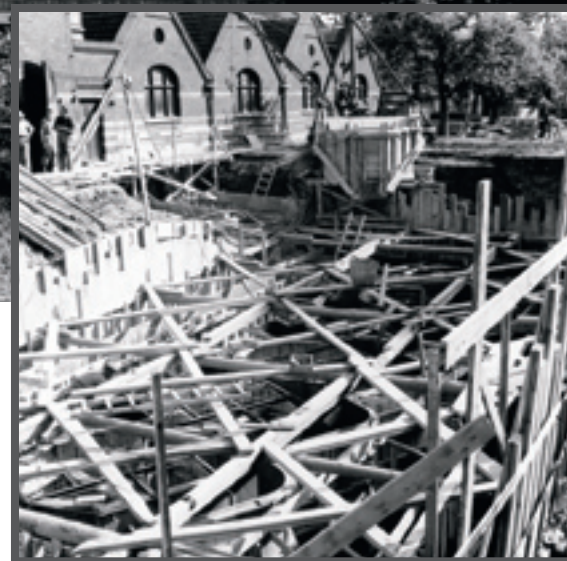
Konstruktion av renskärarbyggnaden.
