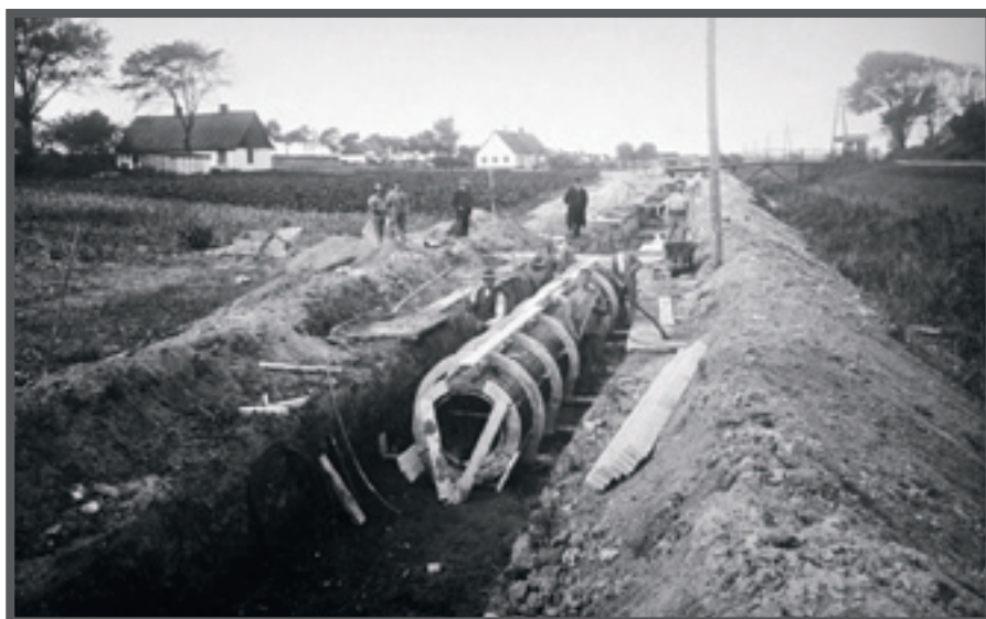
Tryckavloppsledning i armerad betong mellan Rosendal och Sege å, 1908.
