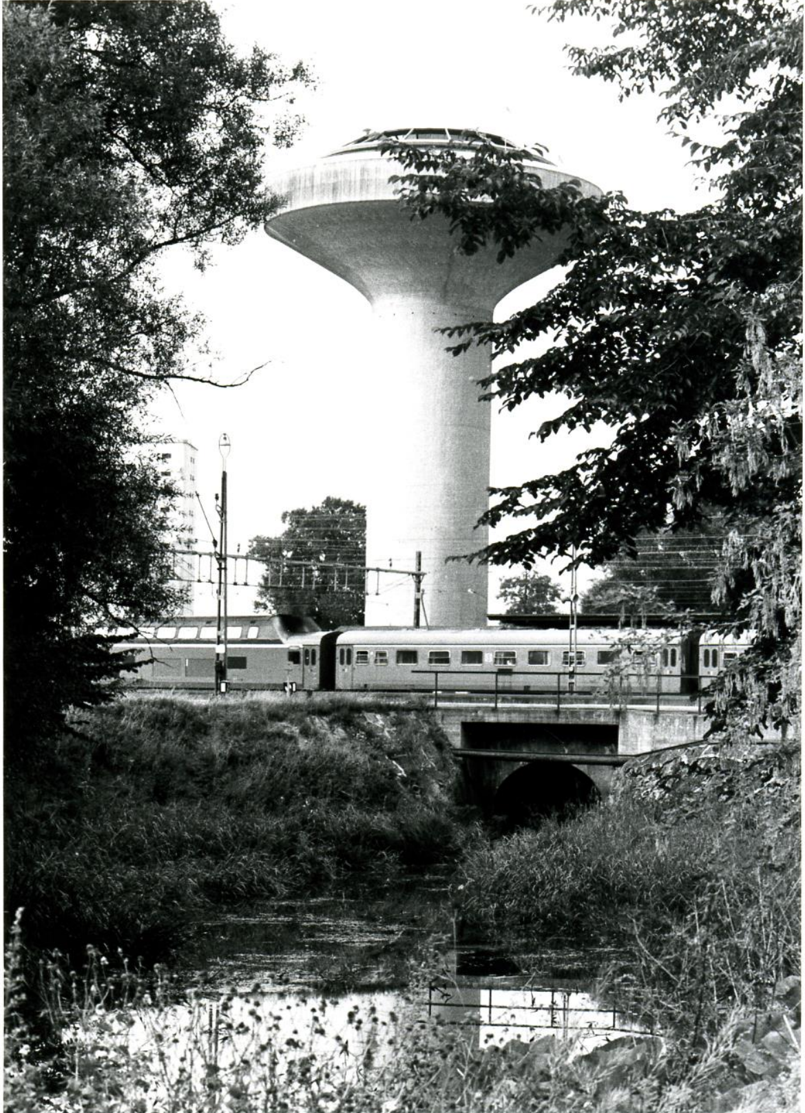
Fig 2:10. Kristianstad 1979. Vattentorn och kanal. Vy från Helge å.
