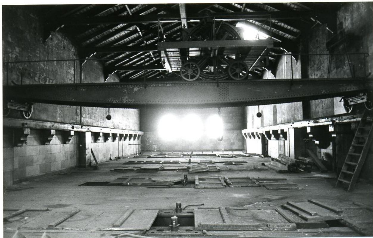
Fig 3:13. Köpenhamn 1979. Vattenverket. Övre maskinsal.
