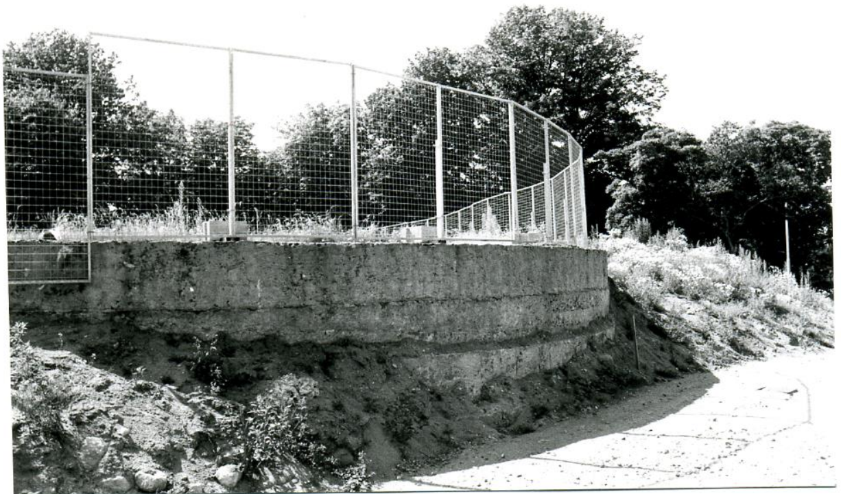
Fig 1:10. Helsingborg 1979. Vattentornets grundmur.
