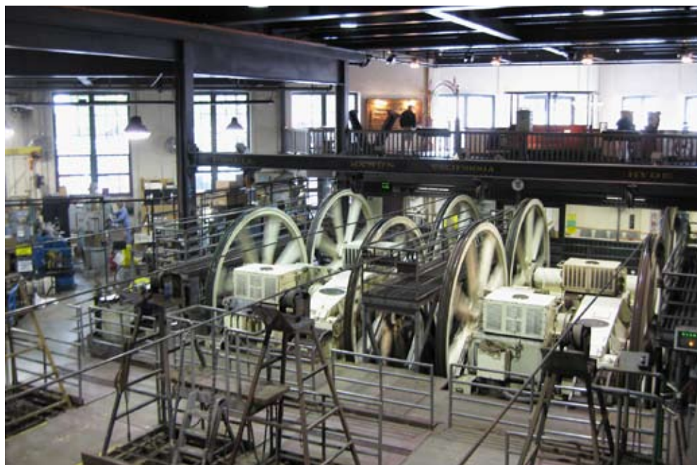
Figur 2. Kabelvagnarna drivs med hjälp av kablar som vinschas upp av kraftiga elektriska motorer. Foto: Olle S Nevenius 2008.
