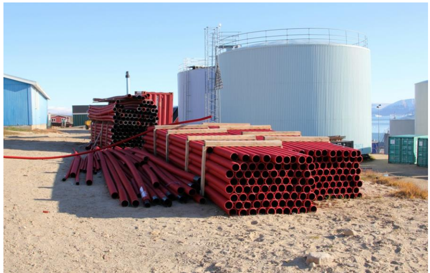
Qaanaaq – vattenverksområde med dricksvattenreservoarer
