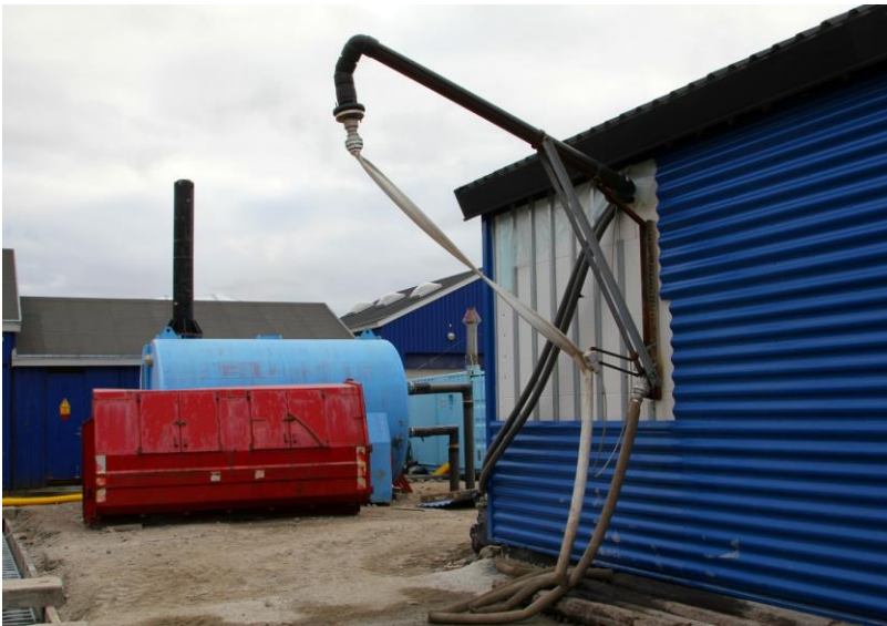
Upernavik - hämtningsstation för tankbil från avsaltningsanläggning
