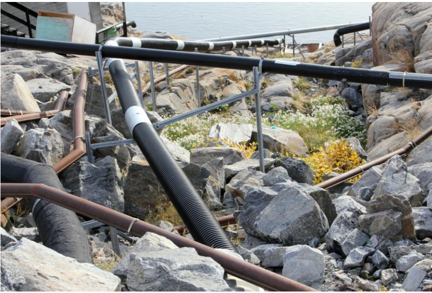
Ummannaq – vatten och elledningar
