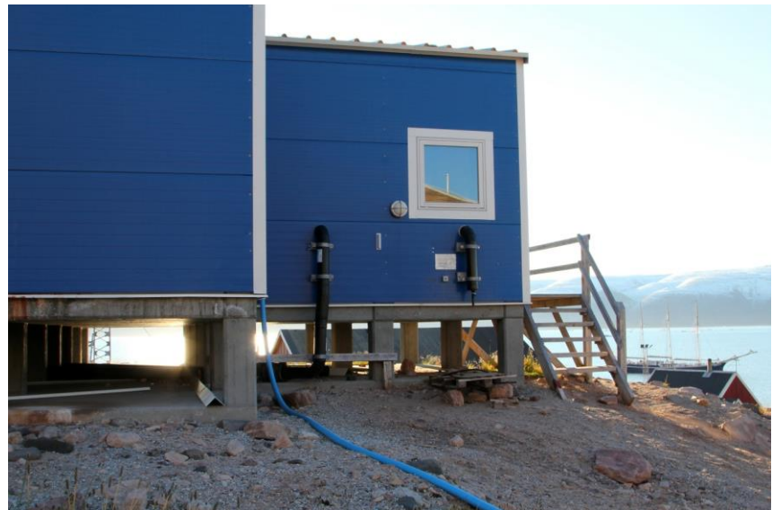
Siorapaluk – vattenverk med tappanordning
