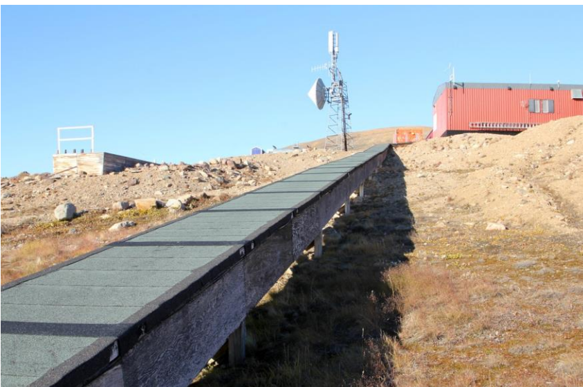
Qaanaaq – vattenledningar mm i träkulvert
