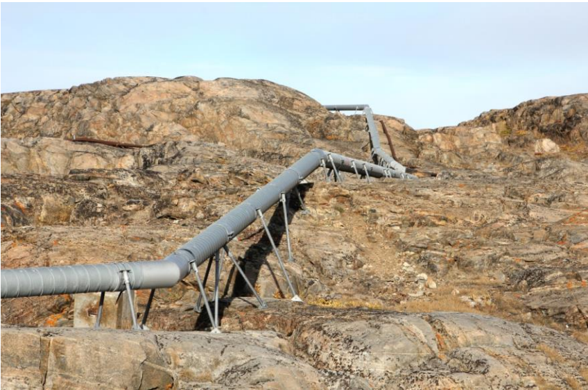
Uummannaq - råvattenledning
