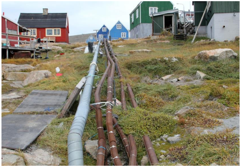
Upernavik - vatten och elledningar
