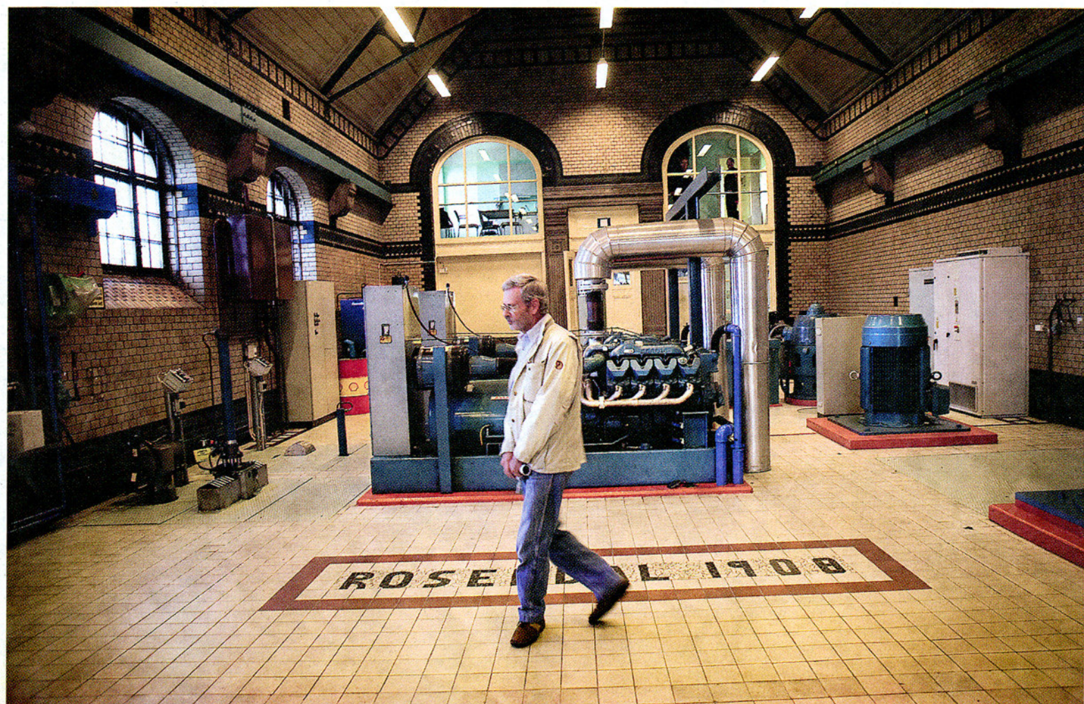
Eber Ohlsson är full av berättelser från pumpstationens och VA-verkets historia. Den stora maskinhallen ser ut ungefär som den gjorde när den invigdes 1908. Fast utrustningen är modern.
