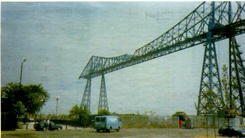
Hängfärjan över floden Tees i norra England är fortfarande i drift. Ett tiotal bilar tar gondolen varje tur. Det är som att åka med en av vägverkets gula linfärjor, fast hängande i luften.
