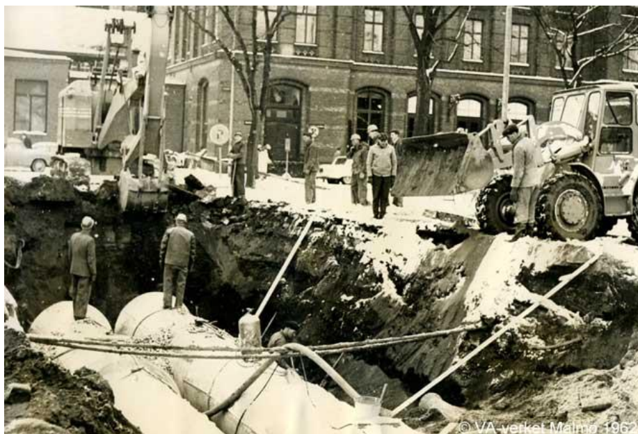
Arbetet med tryckavloppsledningarna Turbinen-Sjölunda vid Malmö C den 25 februari 1962.
