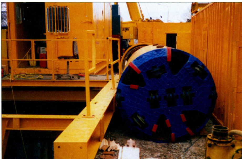
VA-verket i Malmö tar till mikrotunnelborrning för att komma fram i området Rosenvång.
