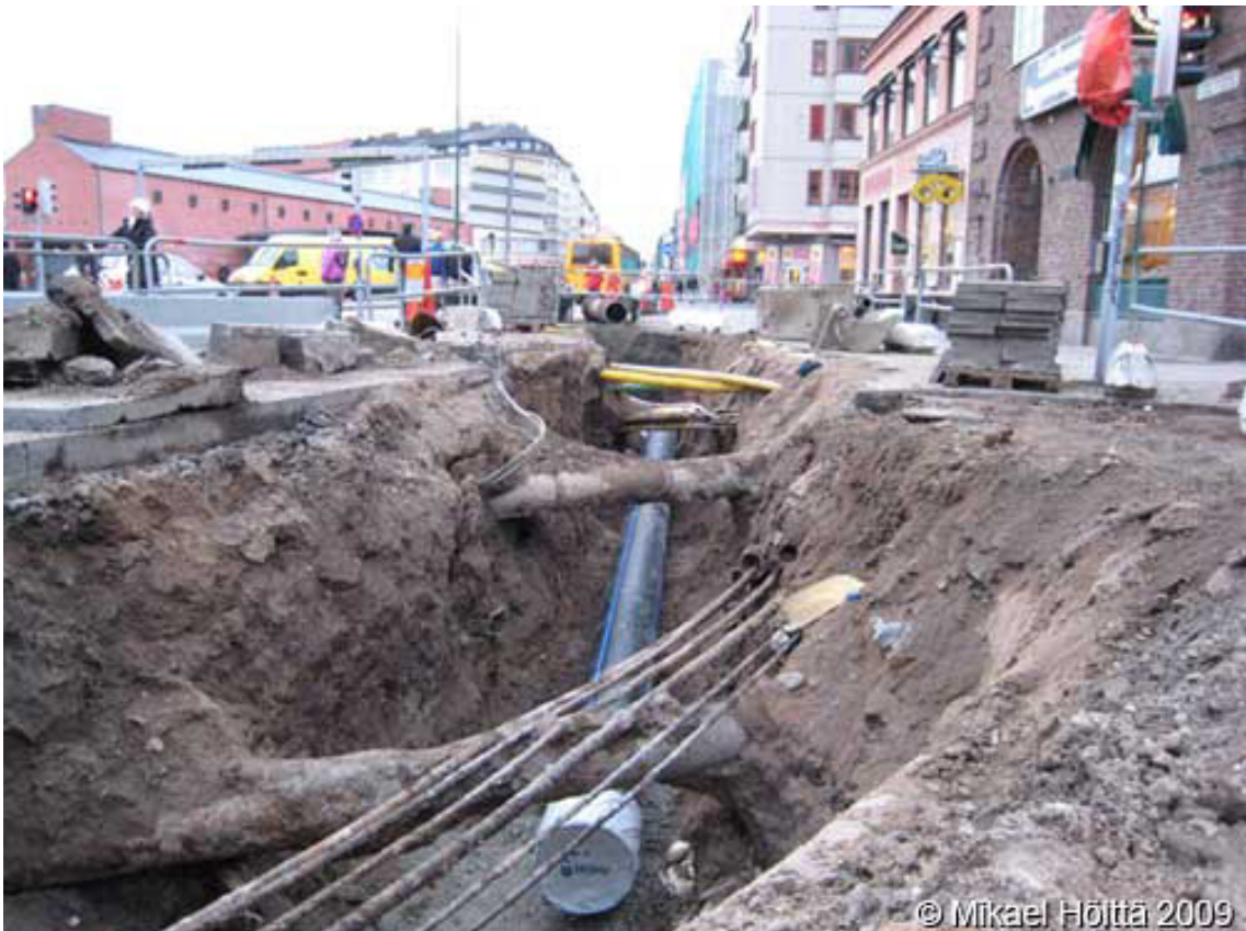
Rörgrav i Östra Förstadsgatan vid Värnhem.
